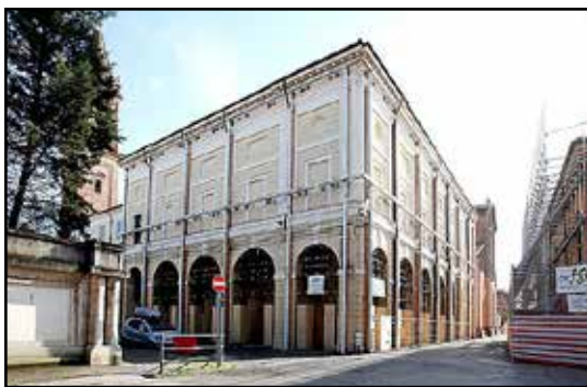
Pinacoteca lavori Cento 2022
